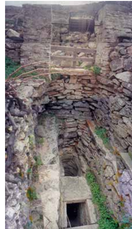
Φωτογραφία της σημερινής κατάστασης του φρέατος.
